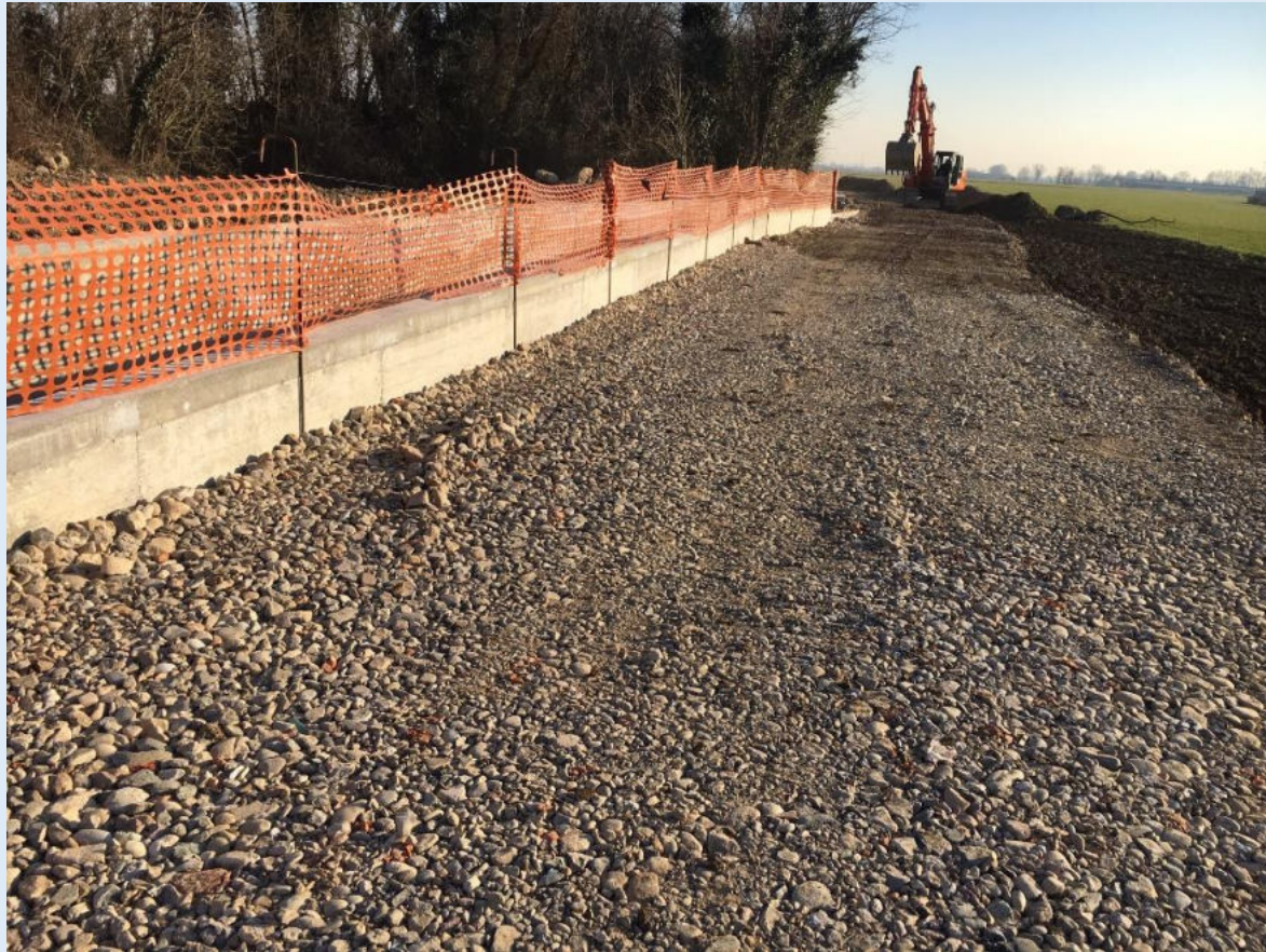
Aggregato artificiale utilizzato come massicciata stradale
