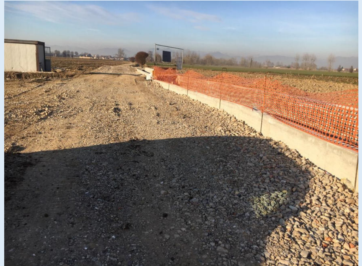
Aggregato artificiale utilizzato come massicciata stradale
