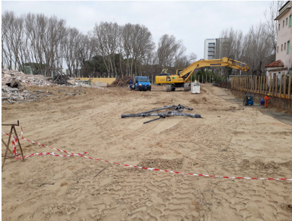
Cantiere in data 28/03/2018 dopo la demolizione dell'edificio e la rimozione della copertura vegetale
